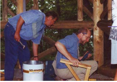
Horst Voigtländer und Klaus Steinmann installieren die Sitzbank.
